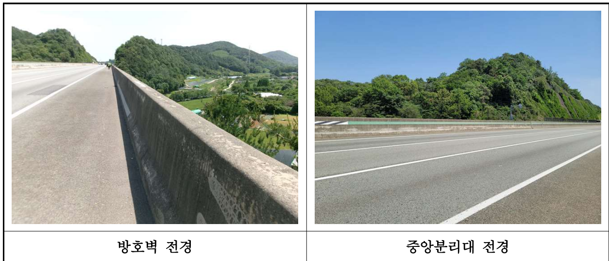
【사진 17.3.24】 방호벽 및 중분대 전경
