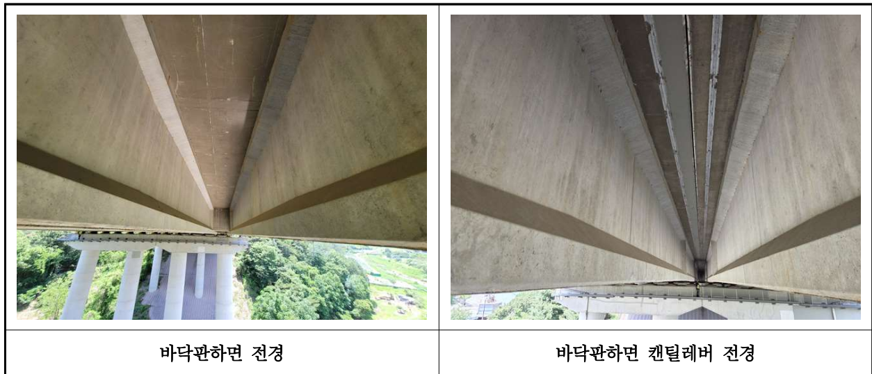
【사진 17.3.2】 바닥판하면 전경
