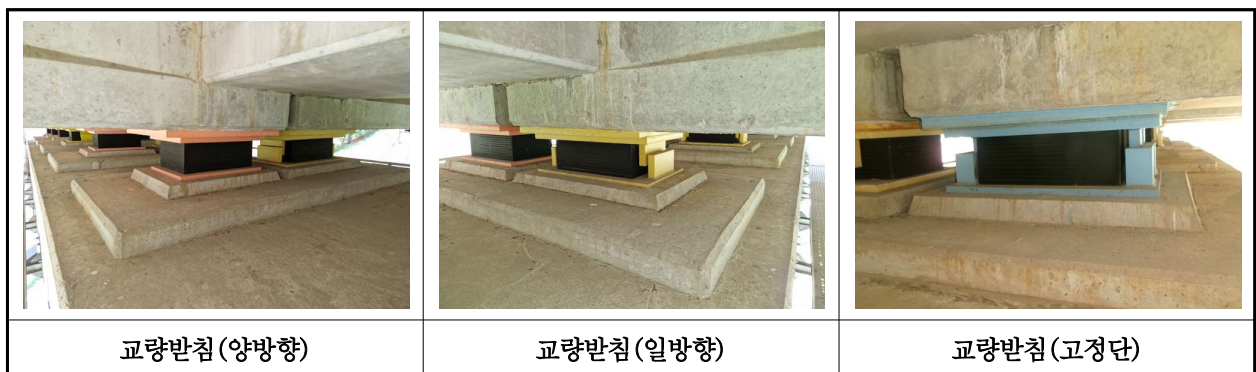
【사진 17.3.13】 교량받침 전경
