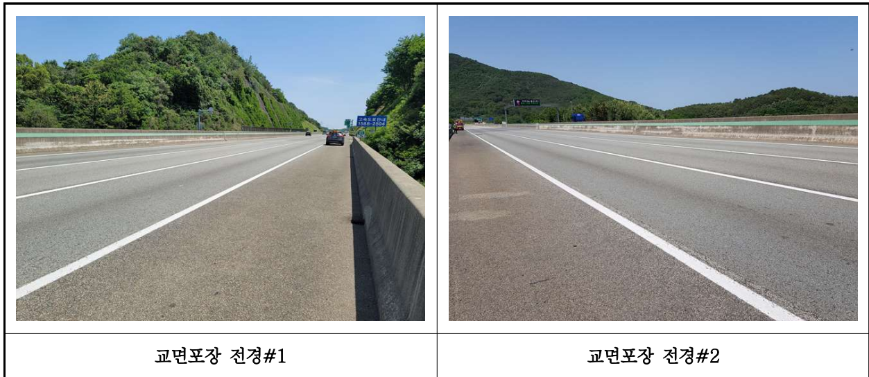
【사진 17.3.20】 교면포장 전경
