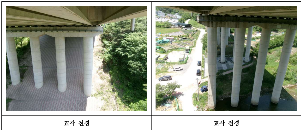
【사진 17.3.10】 교각 전경
