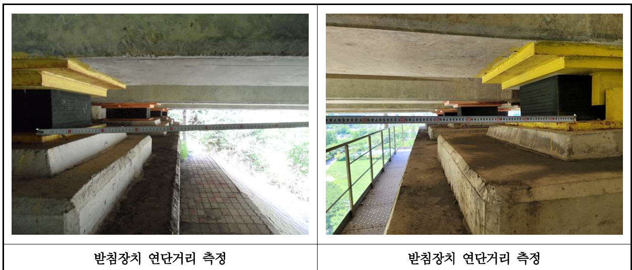
【사진 17.3.15】 교량받침장치 연단거리측정
